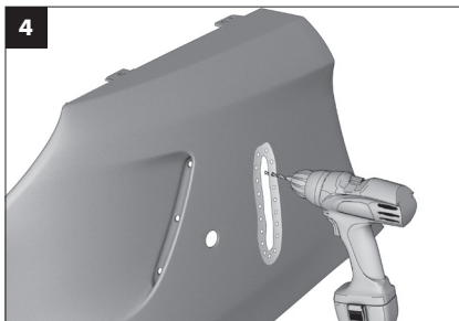
4 In den V-förmig geschnittenen Rand Löcher (Ø ca. 3 mm) bohren.
